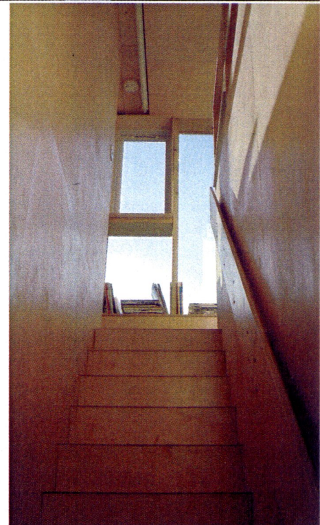
L'accès au plateau entièrement en bois
